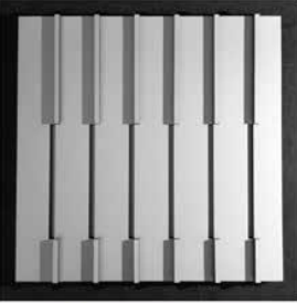
La sur-épaisseur du motif en relief porte à 15 centimètres l'épaisseur totale de ce parement de béton : 10 centimètres de base et 5 centimètres pour le relief.
