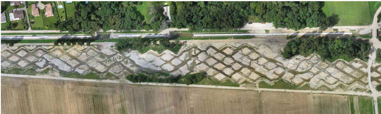
Georges Descombe architecte, renaturalisation de la rivière de l'Aire, Bassin Genevois, 2004
