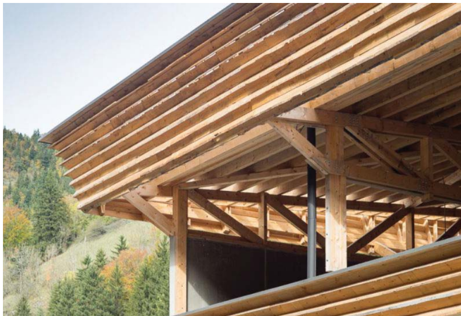
Atelier PNG, centre de déchetterie, Villard de Lans, 2020
