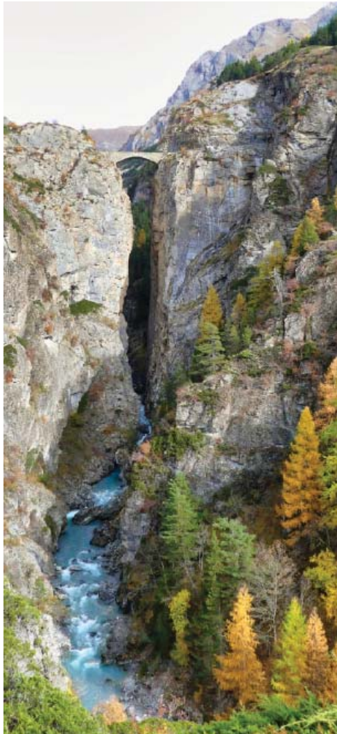
Pont du Châtelet, Saint Paul sur Ubaye
