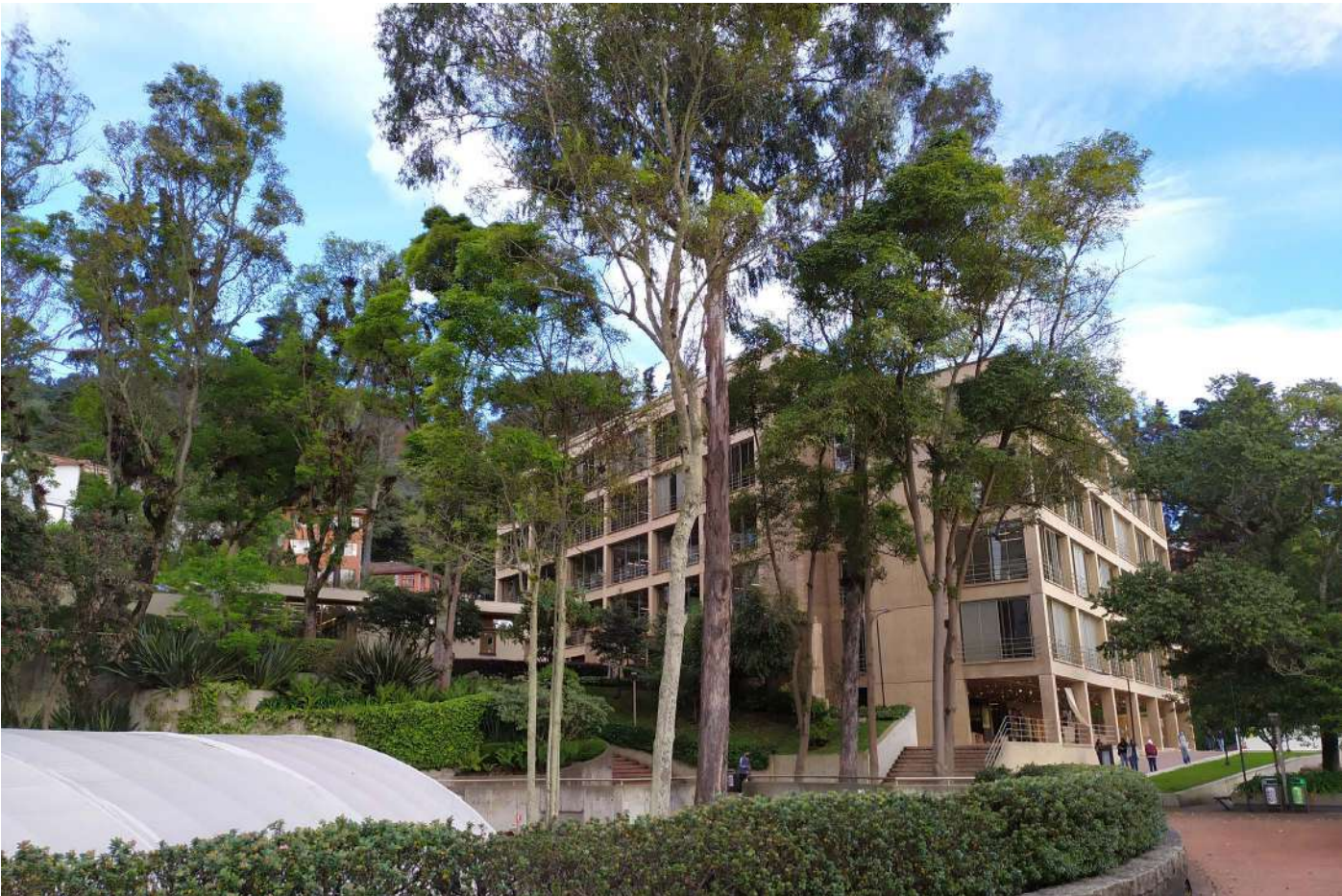
Photo Personnelle, Inès Aguetaz. Vue de l'extérieur du bâtiment d'architecture, Université de Los Andes, Bogota
