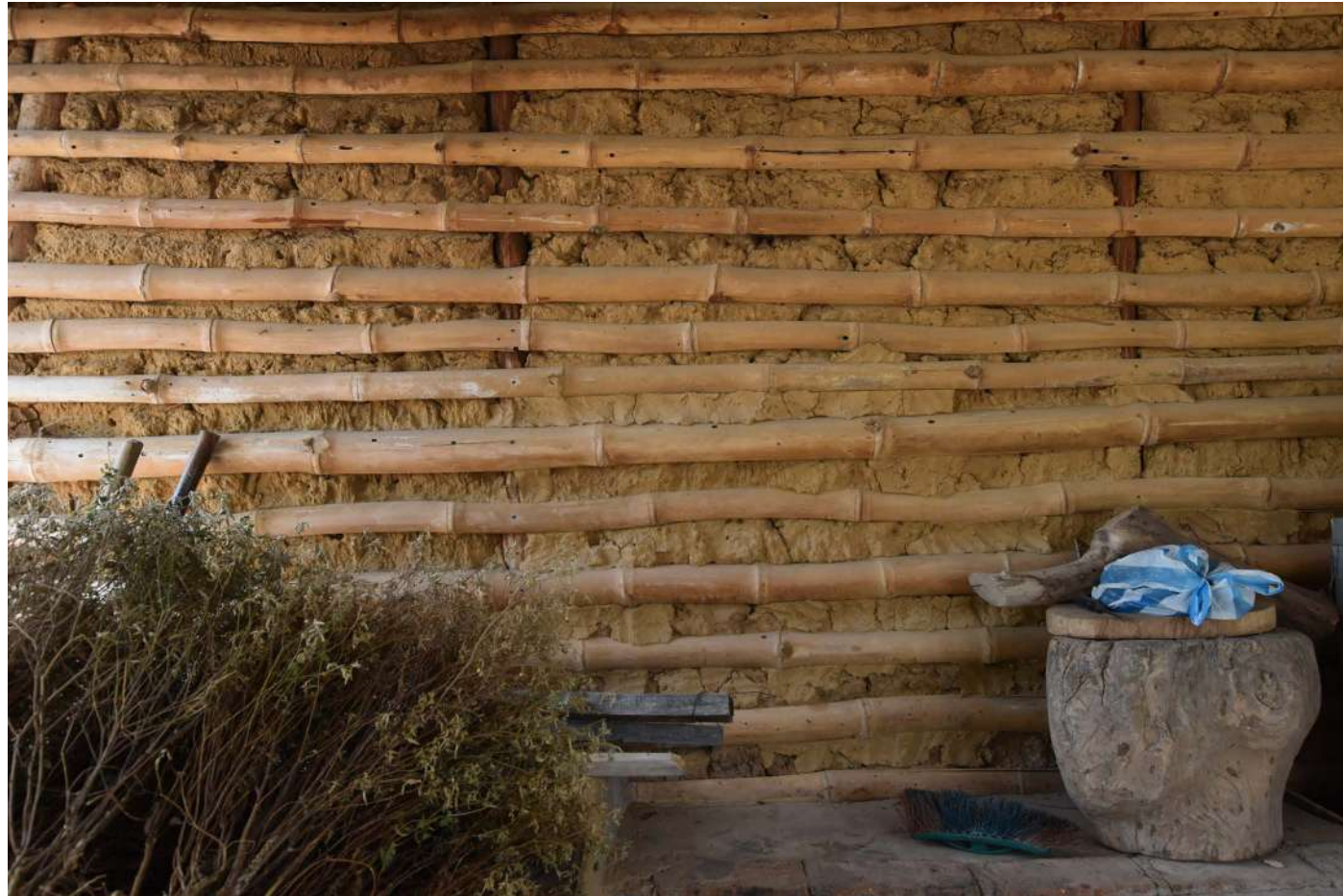
Photo Personnelle, Inès Aguetaz. Mur en terre, Désert de la Tatacoa, Colombie
