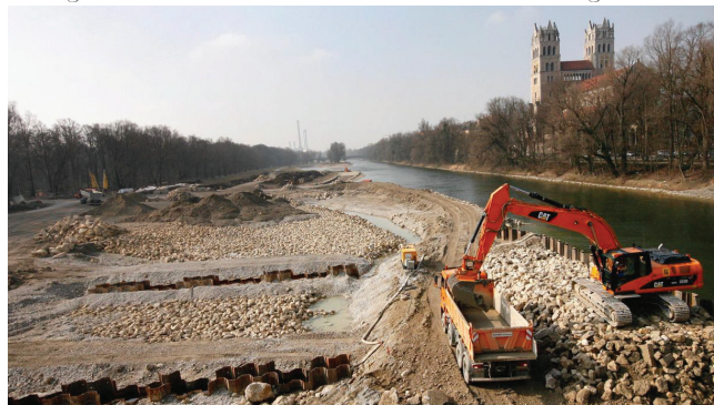
Figure 5 Travaux lors de renaturation des berges de l'Isar
