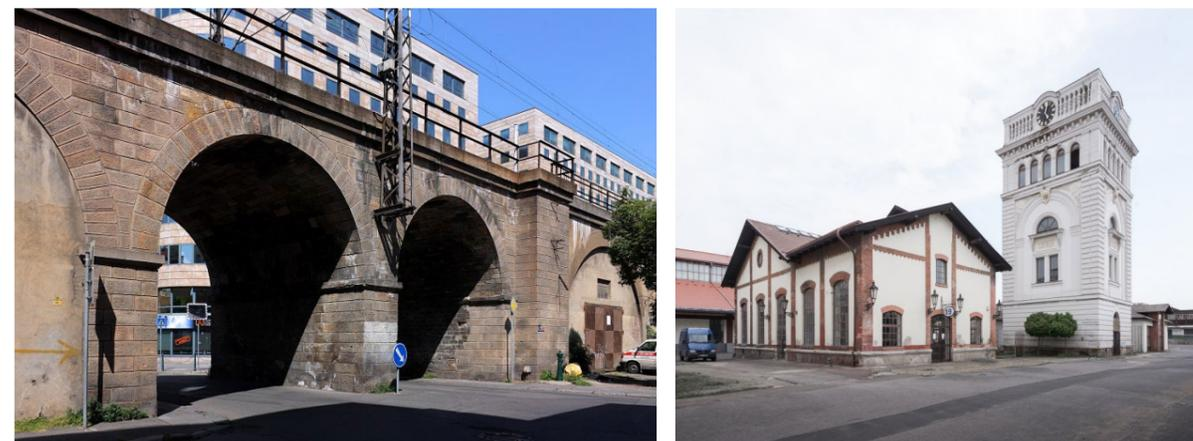
Certaines sections du viaduc ont dû être rénovées plusieurs fois, et une partie des arches sont désormais remplacées par des structures préfabriquées en béton. Malgré ces rénovations, qui auraient pu être un levier pour l'introduction de nouvelles activités dans ces espaces, les arches n'hébergent plus aucune activité autre que du stockage et
