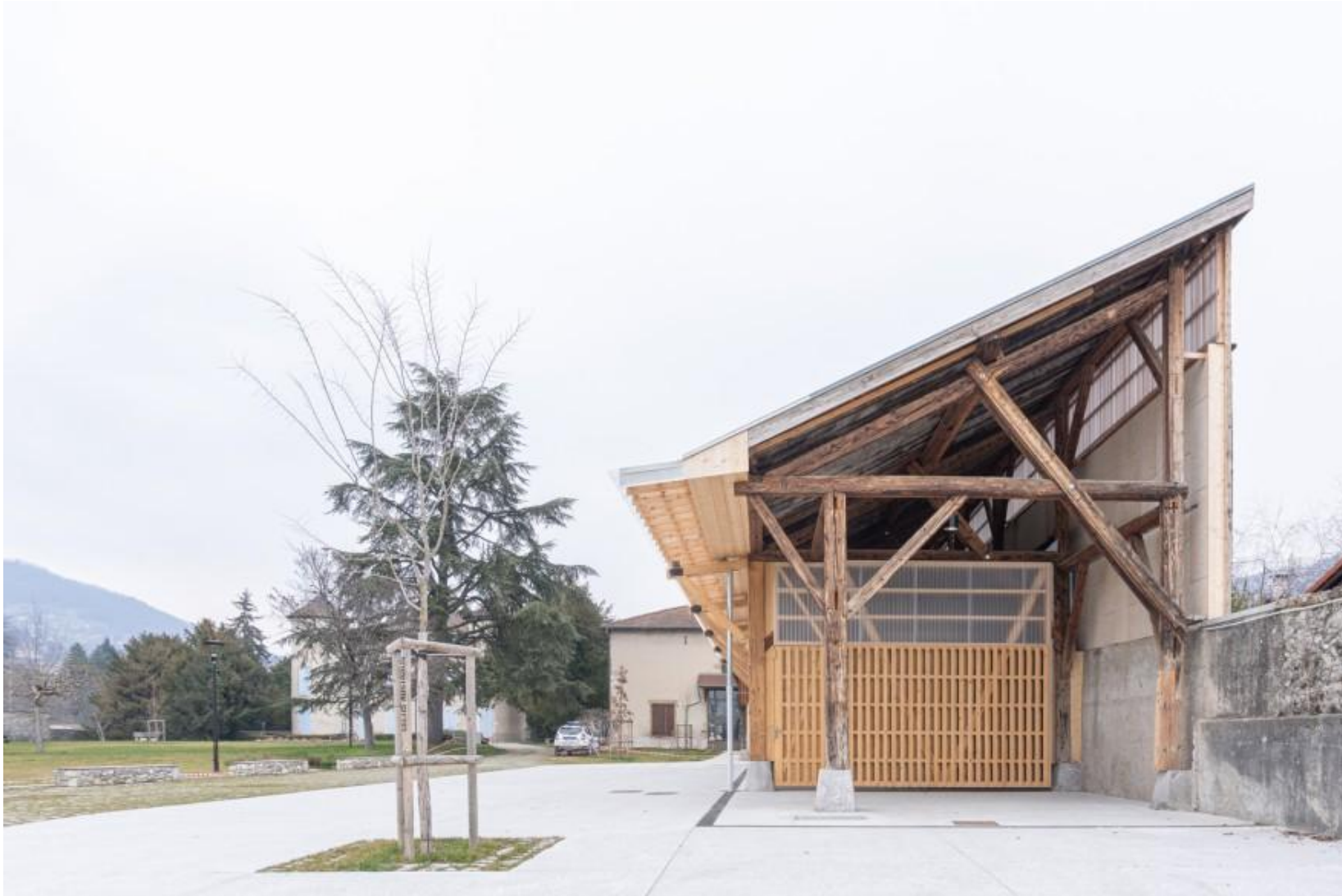
REALISATIONS ENSEIGNANTS : HALLE A COUBLEVIE PNG ARCHITECTES
